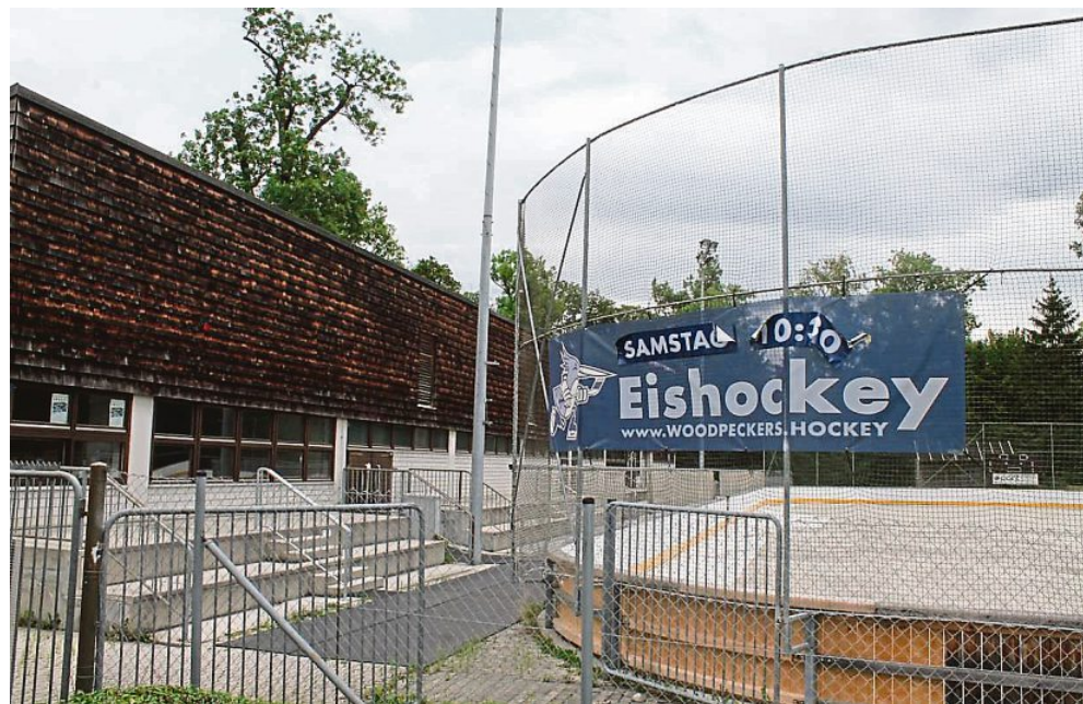
Risse, unebene Betondecke, Schimmel: Die Kunsteisbahn ist marode. Nun entschied sich der Hauptausschuss für einen Neubau – dort, wo sich jetzt Tennisplätze befinden. FOTO: ANS
